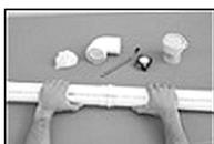
**d)** Encaixar a ponta chanfrada do tubo no fundo da bolsa, recuar 5mm no caso de canalizações expostas e 2mm para canalizações embutidas, tendo como referência a marca previamente feita na ponta do tubo. Esta folga se faz necessária para a dilatação da junta.
