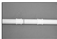
**C)** A solução de problema com Luvas de Correr dispensa o uso de adesivo, pois as luvas possuem anéis de borracha para vedação. O trecho danificado deve ser substituído por um novo segmento do mesmo tipo de tubo. Use duas Luvas de Correr, uma em cada extremidade;
