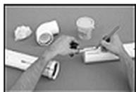
**b)** Marcar a profundidade da bolsa na ponta do tubo;
