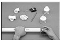
**a)** Verificar se a bolsa da conexão e a ponta dos tubos a ligar estão perfeitamente limpas. Utilizando uma lixa d'água, tirar o brilho das superfícies a serem soldadas, objetivando aumentar a área do ataque do adesivo;
