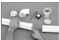
**c)** Aplicar a Pasta Lubrificante TIGRE no anel e na ponta do tubo. Não usar óleo ou graxa, que poderão atacar o anel de borracha;
