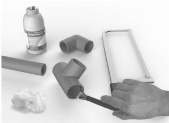
**Passo 1:** com o auxílio de um pincel, aplique o Adesivo Especial TIGRE na conexão e em seguida na ponta do tubo.
