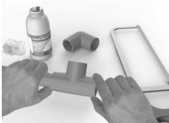
**Passo 2:** encaixe de uma vez as extremidades a serem soldadas, dê ¼" de volta e mantenha a junta sob pressão manual por aproximadamente 30 segundos, até que o Adesivo adquira resistência.
